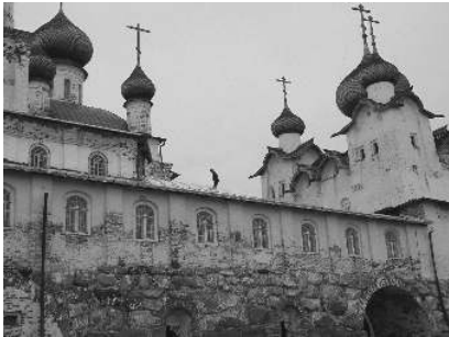
Реставрация кровли Прачечного корпуса
